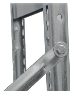
Ein Kreuzverband besteht aus zwei geformten Stangen, die überkreuzt montiert werden, um Sicherheit und Stabilität zu garantieren.
